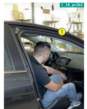
Bild 2. Vor dem Einbau wird mit einer Magnetfussantenne (1) sowie dem angeschlossenen Gerät an der USB-Schnittstelle überprüft, ob das Gerät kompatibel und der Empfang mit einer Scheibenklebeantenne möglich ist.
